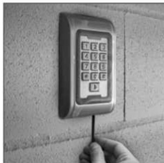
6 • Encaje el TEC100 en la tapa trasera, y apriete los tornillos de fijación.
